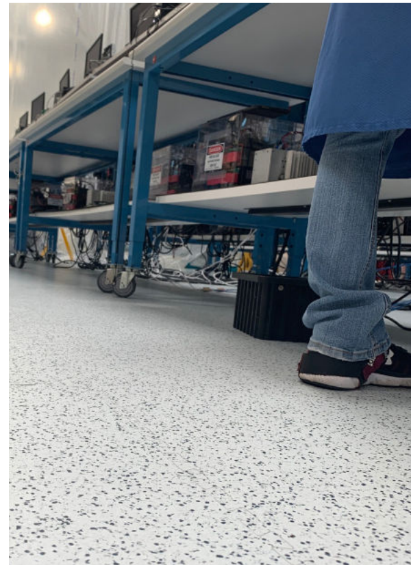
GroundLock Extreme instalado en Advanced Motion Controls. Observe que las juntas de las baldosas son casi invisibles.
